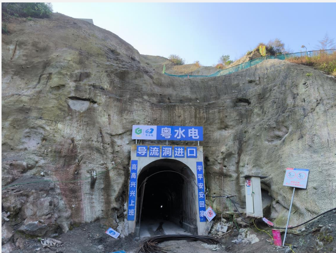
斑竹沟水库导流洞建设
