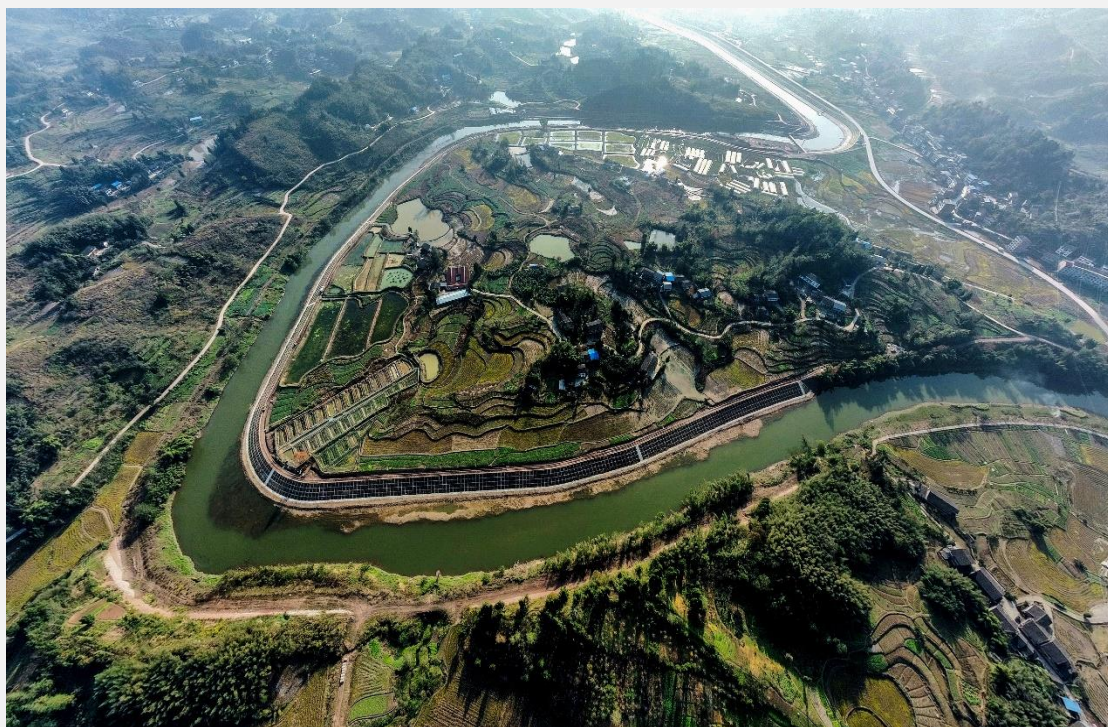
达川区铜钵河（一期）防洪治理工程
