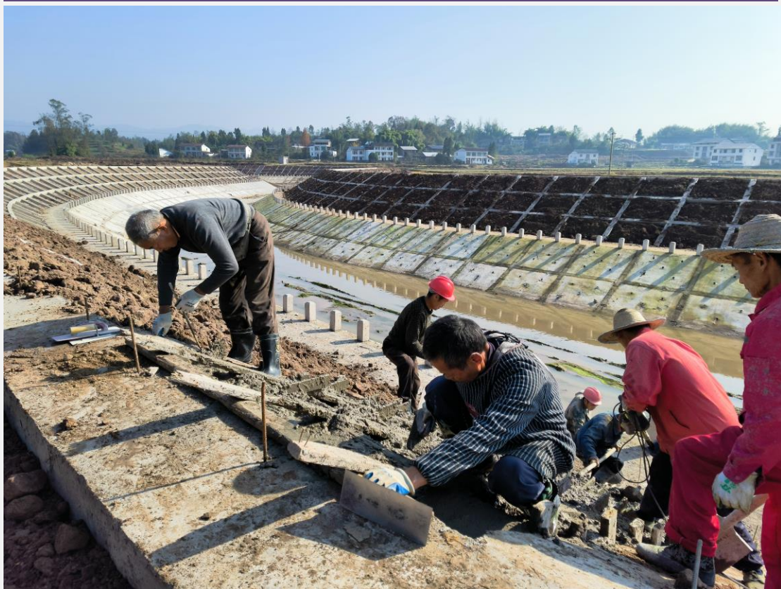
大树东照社区李家河沟防洪治理工程
