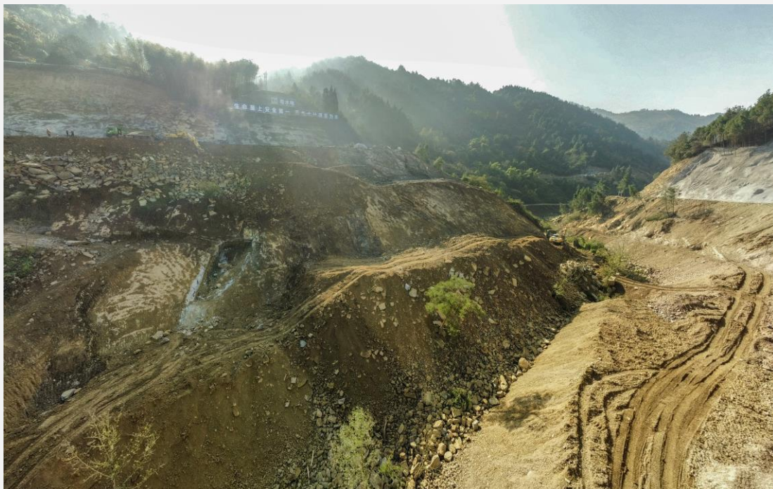
斑竹沟水库大坝修建清基和边坡开挖
