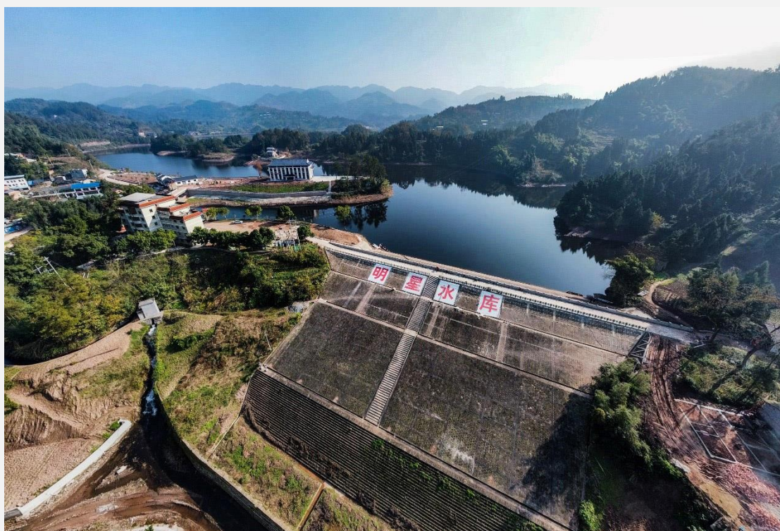
达川区明星水库大坝除险加固工程
