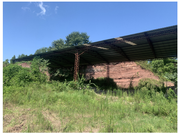
照片 4：项目拟改造利用的生产车间厂棚
