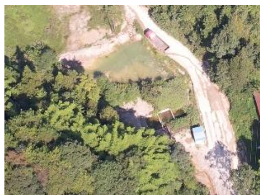
生产车间西北面初期雨水池、 车辆冲洗废水沉淀池
