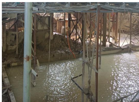
生产车间内清水池
