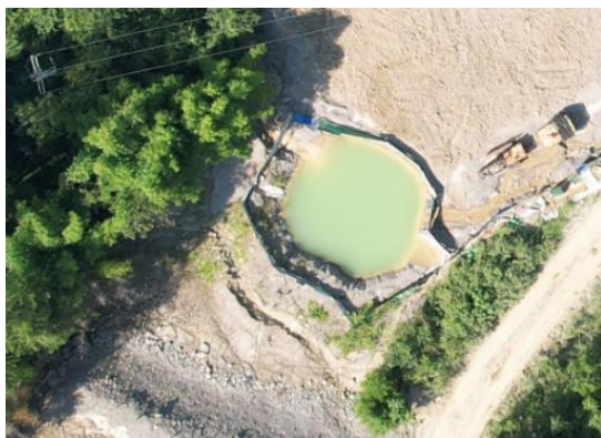
生产车间东北面初期雨水池
