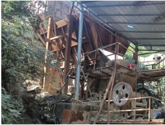
未封闭的进料口（需封闭）
