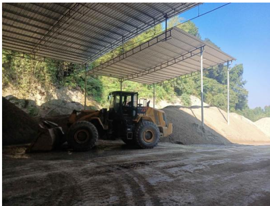
半封闭的产品堆场
