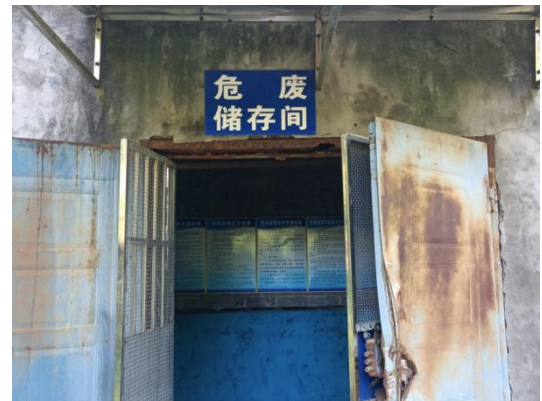
危险废物暂存间（外部，需完善标识）
