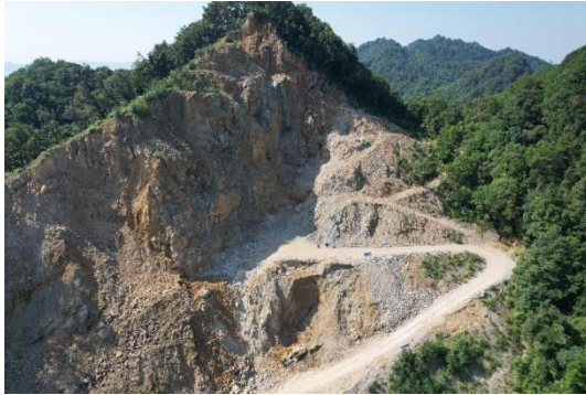
已形成的高陡坡（需进行防垮塌处理）
