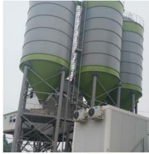
混凝土搅拌站料筒密闭
