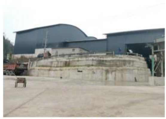
地面硬化及车间封闭
