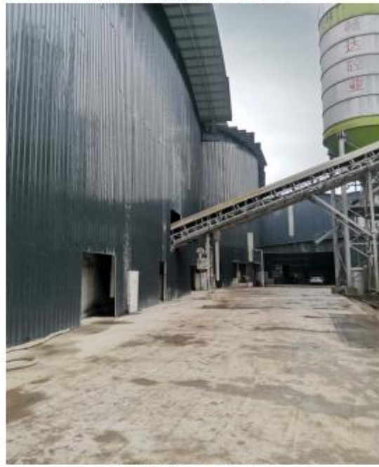
地面硬化及车间封闭
